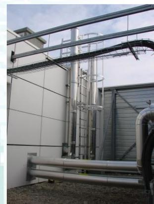
*Production EG par 1 GF CIAT de 350 KW, production chaud par une chaudière WIESMANN de 640KW, centrales de traitement d'air Air Clean sante de CIAT, supervision et régulation TAC-SCHNEIDER*
