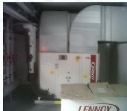
*Production EG par 2 GF LEENOX de 105KW, production chaud par une Pompe à chaleur de 65 kW, 4 armoires de climatisation de 33KW et une de 14KW type DHCDR LEENOX, centrales de traitement d'air ROTO et DUO de marque ATLANTIC, régulation TAC-SCHNEIDER*
